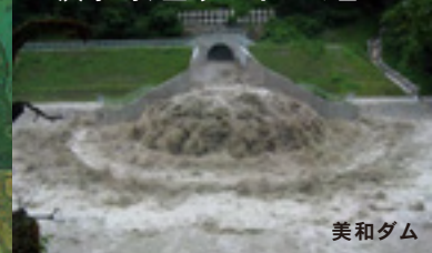
洪水時、土砂バイパス吐口
