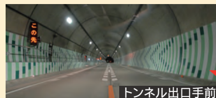
実際の施工済みトンネル内写真→
