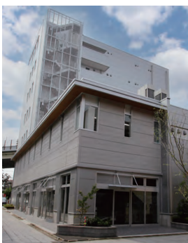
社屋外観(南東面より撮影)
