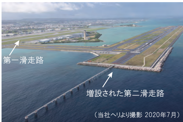
写真1 那覇空港滑走路増設事業の現況
