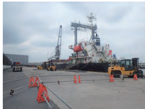
写真2 供用中の岸壁(A岸壁)
