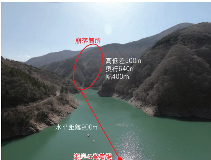
写真2 崩落箇所の状況
