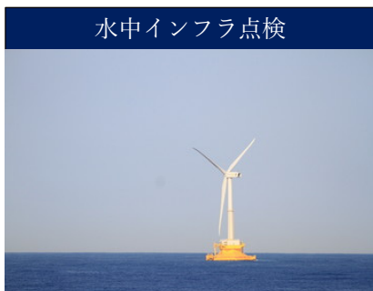
水中インフラ点検 港湾設備、洋上風力、ダム、橋脚などの水中インフラ点検
