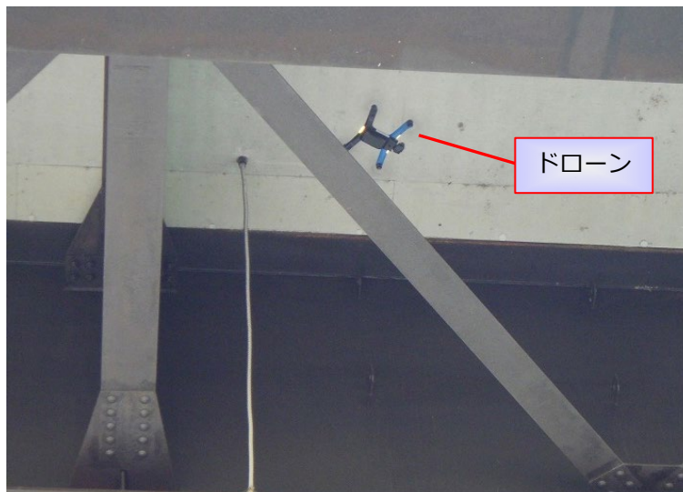
ドローンによる橋梁点検
