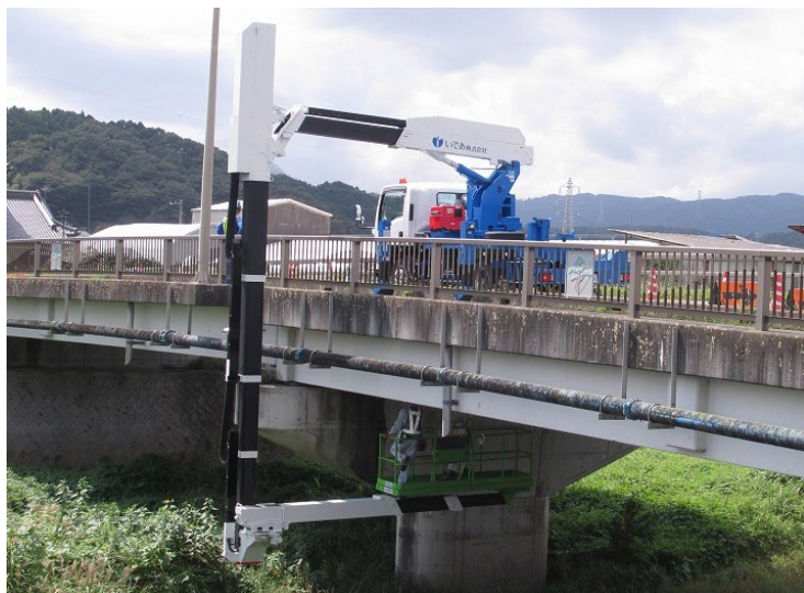
当社保有の橋梁点検車による橋梁点検
