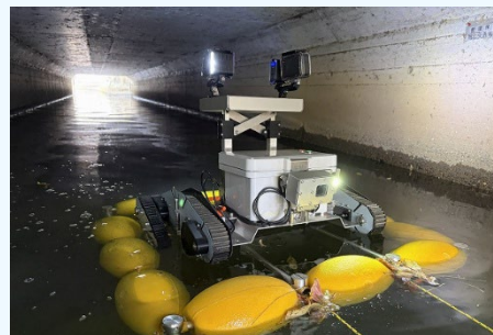
【写真1】水陸両用点検ロボットによる水路点検
