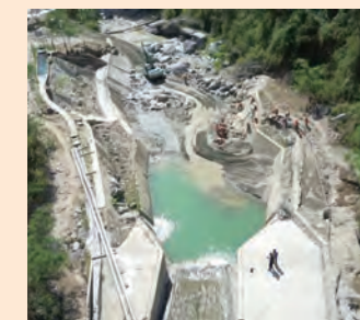
護岸復旧工事の様子(東ティモール国)
