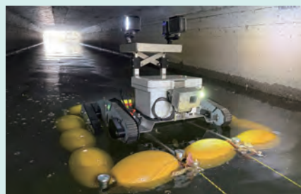
水陸両用点検ロボットによる水路点検
