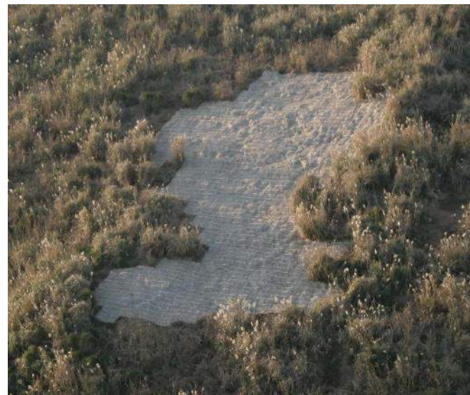
施工直後（平成25年11月）
