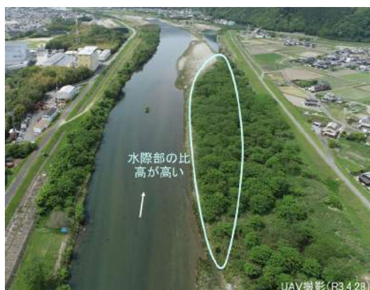
図-2 対象箇所のUAV写真
