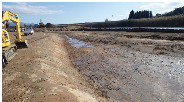
実際の施工風景
