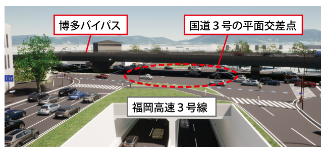
空港口交差点部の3階建て構造
