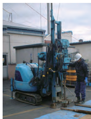
ボーリング調査
