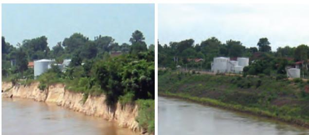
写真3 パイロット護岸工事前後の河岸の状況
