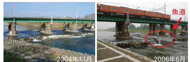
写真1 中央線護床工対策の前後の状況
