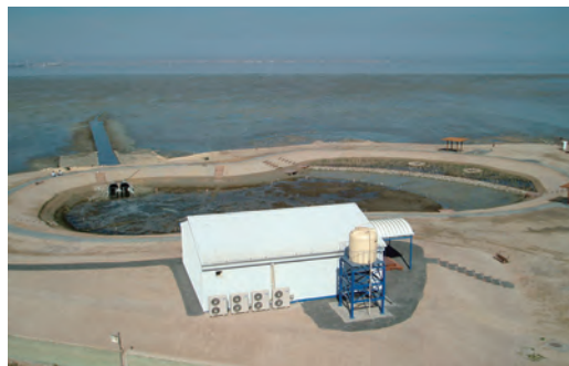
写真2 建設された実験干潟
