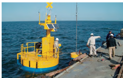
写真3 モニタリングブイの設置
