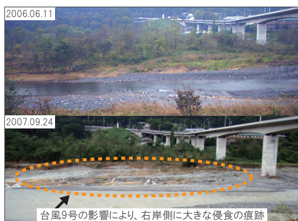
図3 多摩川羽村大橋下流右岸の状況
