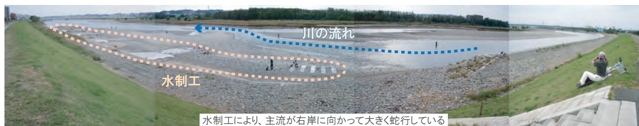
図4 多摩川左岸・上石原付近の水制工
