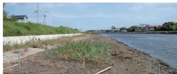
写真2 工事後1年目の現地の状況
