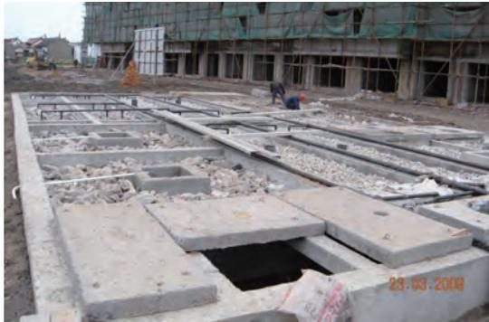
写真1 ろ材である礫の充填状況
