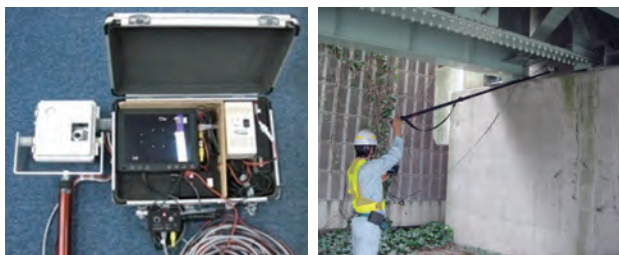
写真1 リモートモニターカメラによる点検 (左: リモートモニターカメラ機材 右: 支承の確認状況)
