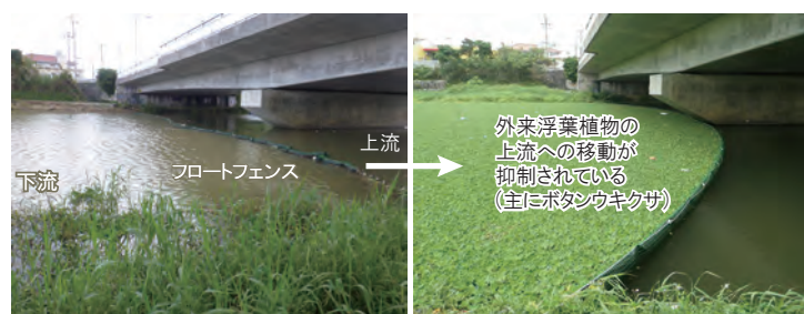
写真3 設置したフロートフェンス
