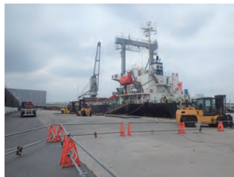
写真2 供用中の岸壁(A岸壁)
