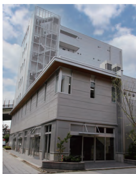
社屋外観(南東面より撮影)
