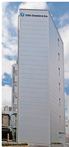
社屋外観(北面より撮影)
