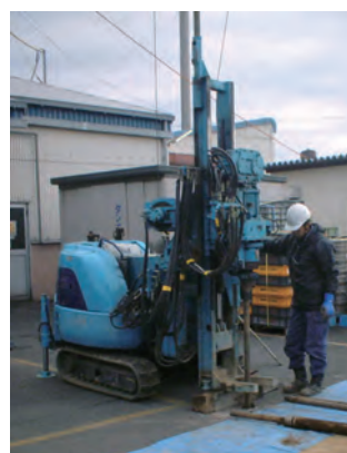
ボーリング調査
