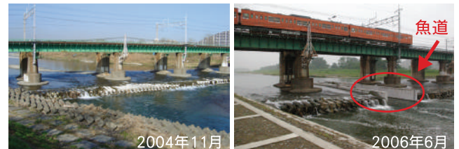
写真1 中央線護床工対策の前後の状況
