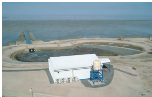
写真2 建設された実験干潟
