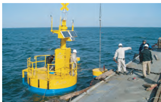
写真3 モニタリングブイの設置
