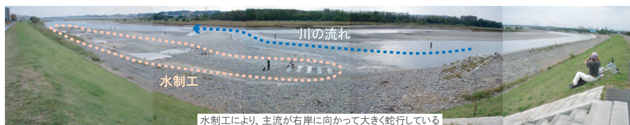
図4 多摩川左岸・上石原付近の水制工
