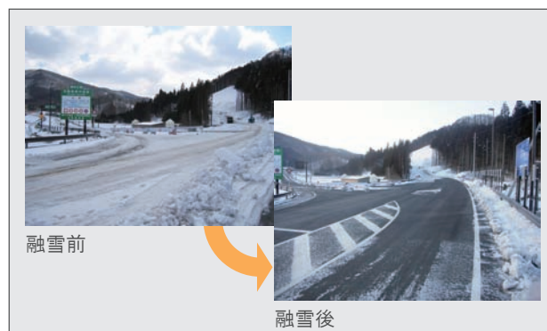
写真3 採用事例(交差点における融雪効果)
