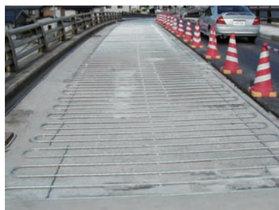
写真1 路面の放熱管配管状況
