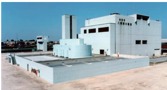
写真7 八潮排水機場(埼玉県八潮市)
