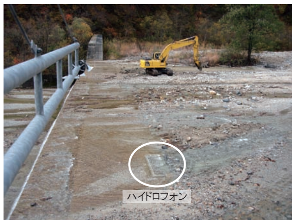
写真2 ハイドロフォンの設置例
