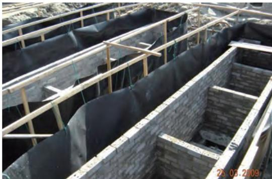
写真3 防水膜とブロック壁で躯体を構築
