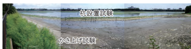
写真6 かさ上げ・杭設置試験
