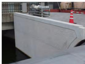
写真4 表面のはつり仕上げ
