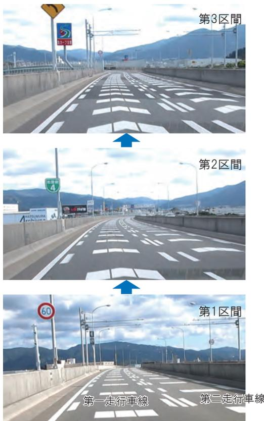
図2 シーケンスパターンの施工事例(福岡高速4号線)
