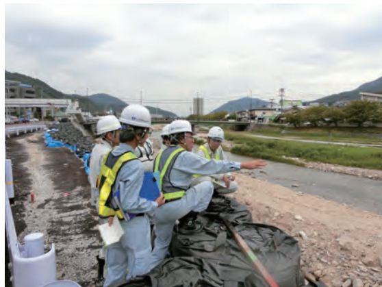
国道2号兼用護岸の被災(発注者との現地合同協議)
