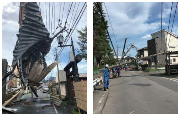
写真1 令和元年房総半島台風による電柱損壊状況 2)
