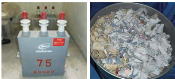
写真1 PCB廃棄物例(左:コンデンサ ※2 、右:感圧紙)
