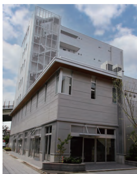
社屋外観(南東面より撮影)
