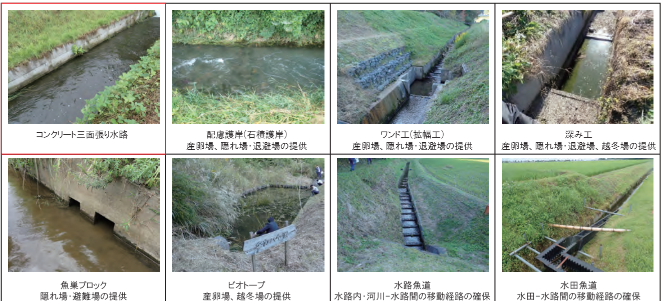
写真1 一般的なコンクリート三面張り水路(上段左端)と、さまざまな生態系配慮施設(主に魚類を対象)
