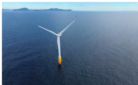
崎山沖2MW浮体式洋上風力発電所(長崎県五島市沖)
